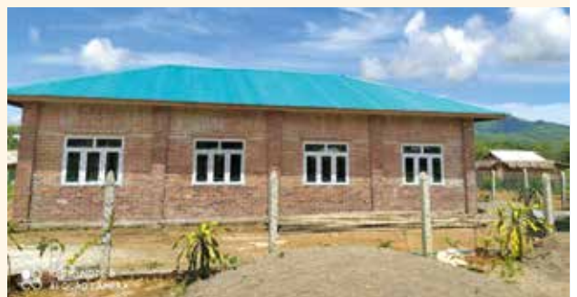
Das neue Missionszentrum – im Bau (oben) und nun endlich fertig (unten) – bietet neue Möglichkeiten.
